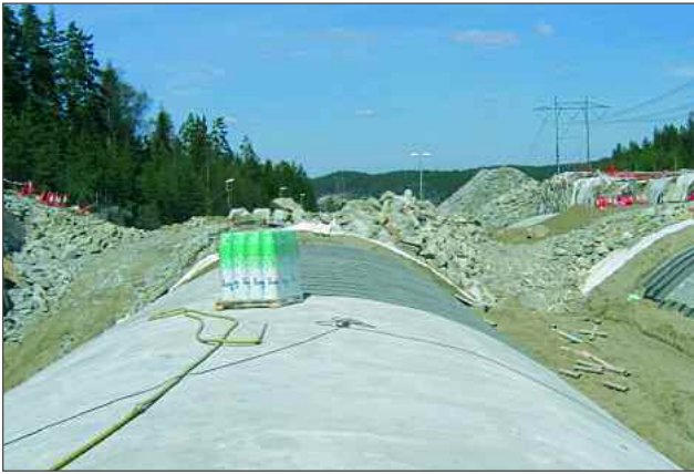
Betongbue, miljøtunnel, 4 felts motorvei
