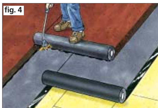
Utlegging, innfesting, sveising
